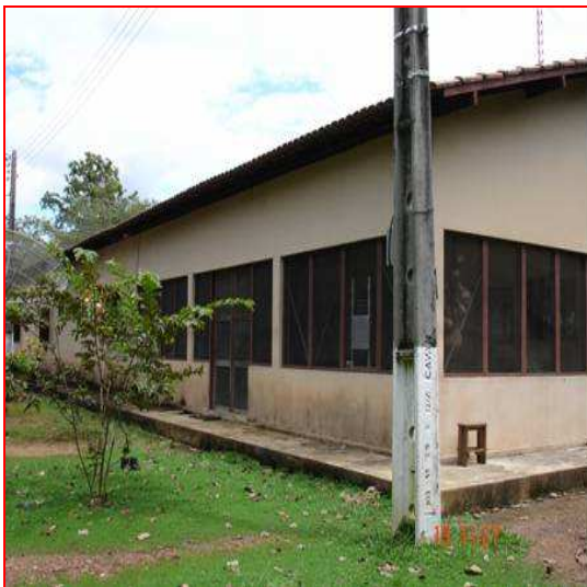
Foto 17. Área externa do alojamento
