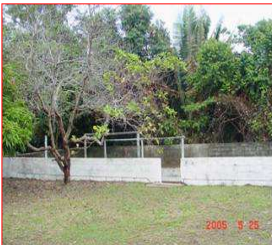
Foto 19. Área externa do alojamento
