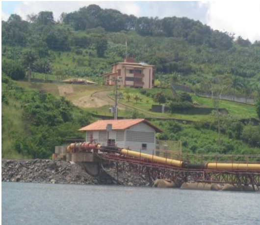
Foto 11. Captação de água do lago para abastecimento da Vila
